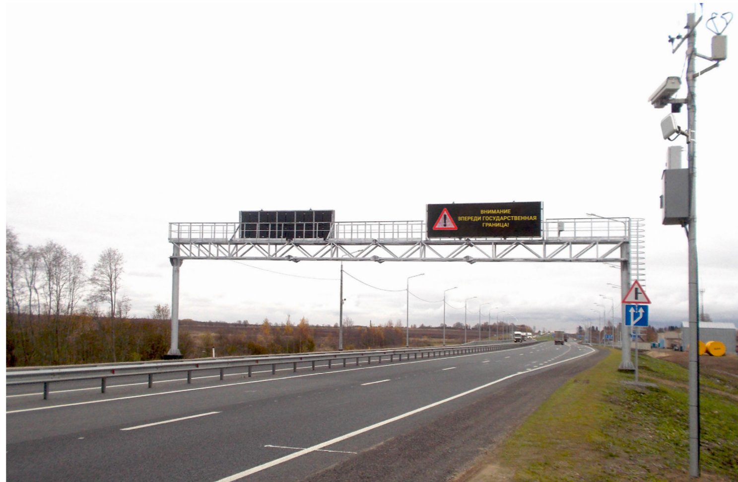
Комплексный пост дорожного контроля метеосистемы и табло переменной информации информируют водителей о текущих погодных условиях на автодороге.
